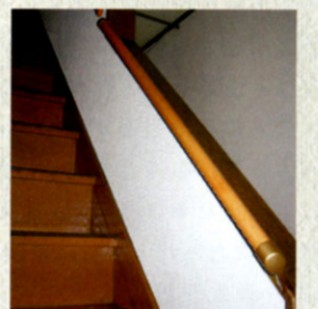
全体的に手すりを取り付け、安全に上り下りできるようにした。
