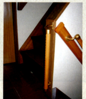
階段の踊り場には、縦手すりを設置。上るときに体を引き寄せやすいオフセットタイプを採用。
