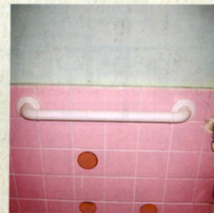
立位保持や立ち座りをサポートする、洗い場の手すり。
