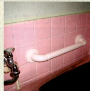
浴槽の周囲の2カ所に手すりを設置したので、浴槽の出入りが楽になった。
