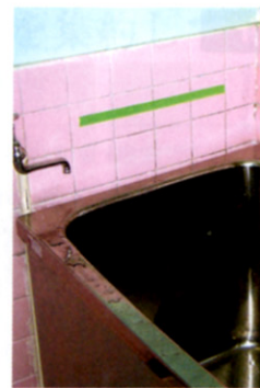
※緑のテープは手すり設置予定の目印。
